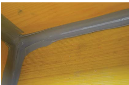
6. Ausstreichen/Abglätten des hervorquellenden Klebstoffs mit Flüssigseife am Finger.
