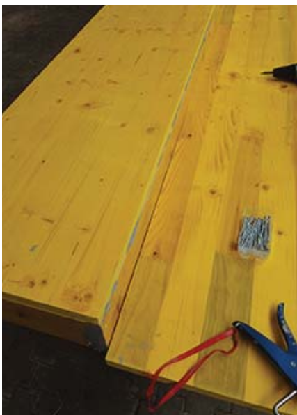
5. Aufgeklebter Boden vor Verschraubung.
