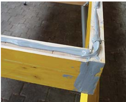
4. Vor der Montage des Bodenteils die Rahmenunterseite mit Klebstoff versehen.
