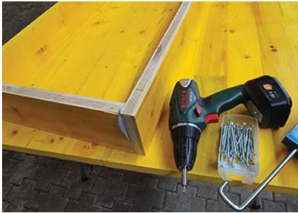
3. Verklebter Rahmen verschrauben.
